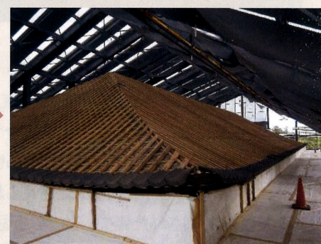
⑥軒平瓦の取付け後(H25.7)
