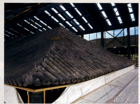
⑧丸瓦が葺かれた状況(H25.10)
