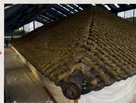
②丸瓦撤去後の状況(H24.5)
