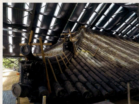
①工事前屋根の状況(H24.4)
